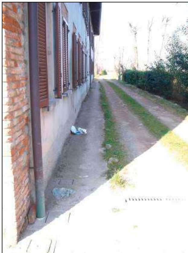
FIG. 45 Particolare pluviale con griglia
