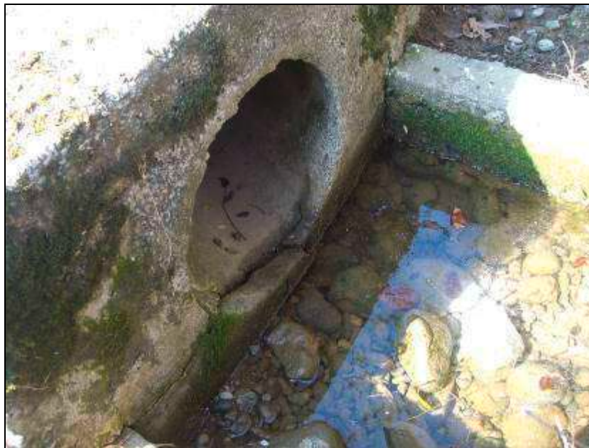
FIG. 27 Corso d'acqua parallelo alla strada
