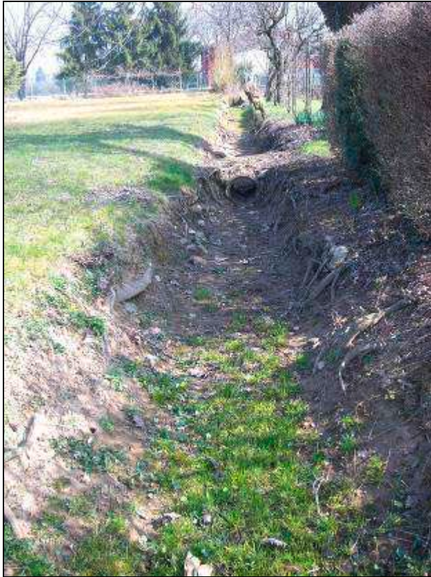
FIG. 40 Particolare corso d'acqua a cielo aperto
