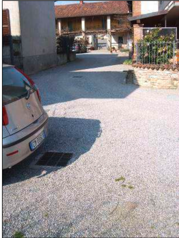
FIG. 47 Griglia con pozzetto per raccolta acque
