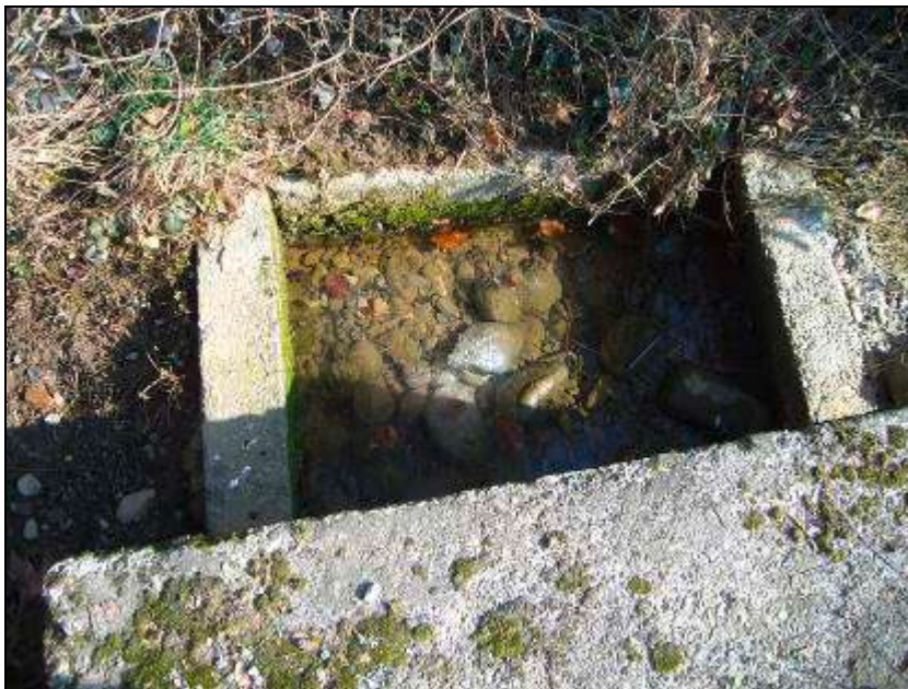
FIG. 26 Corso d'acqua parallelo alla strada
