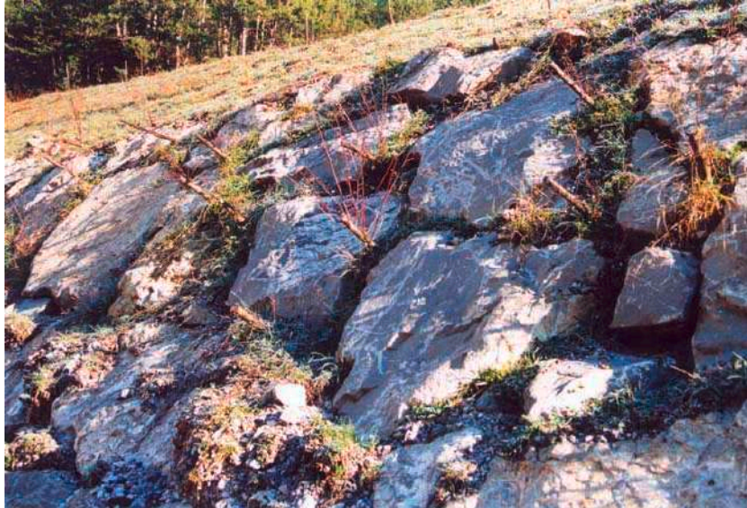
FIG. 24 Esempio tipo scogliera in massi ciclopici con particolare inserimento di talee di salice
