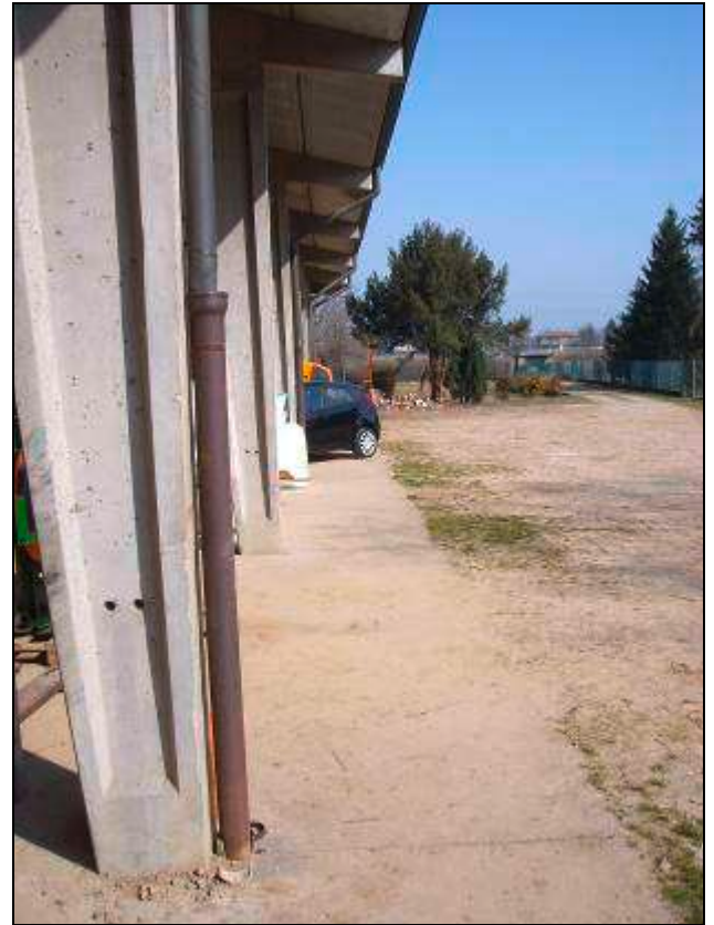
FIG. 34 Panoramica dove si sviluppa il tratto interrato
