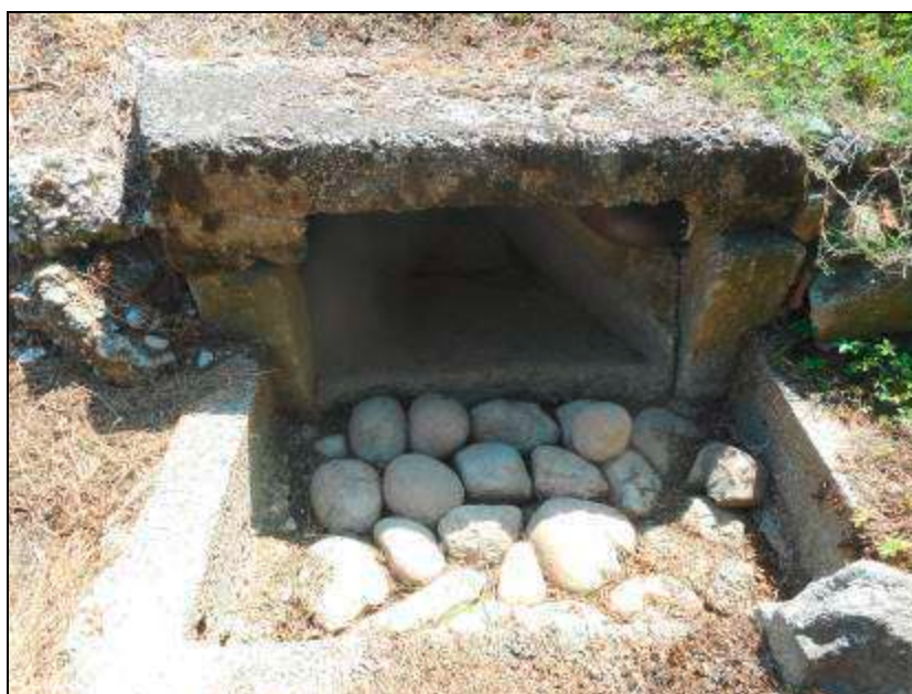
FIG. 32 Particolare Vasca in data Luglio 2021
