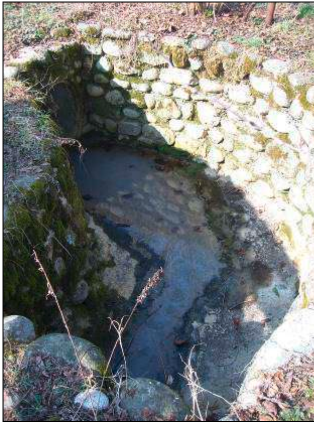
FIG. 33 Particolare tratto a cielo aperto tra due tratti tombati
