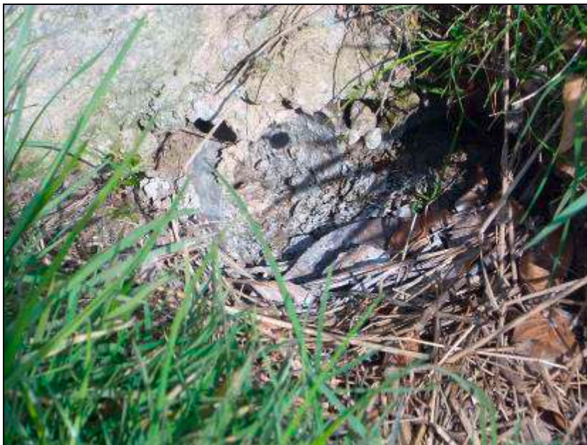
FIG. 15 canale di scarico in alveo
