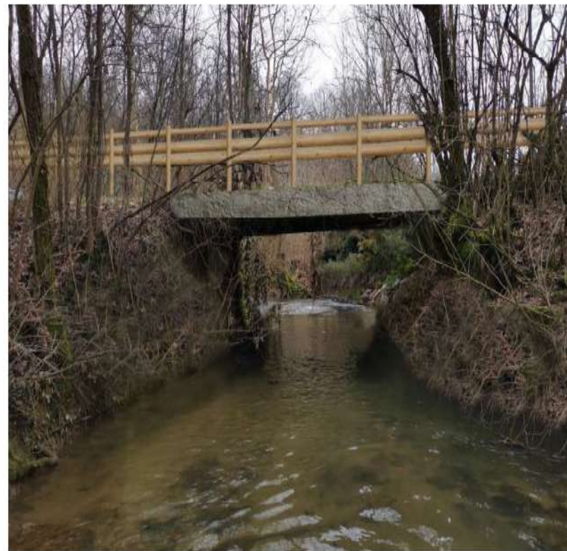
Dopo il ripristino
