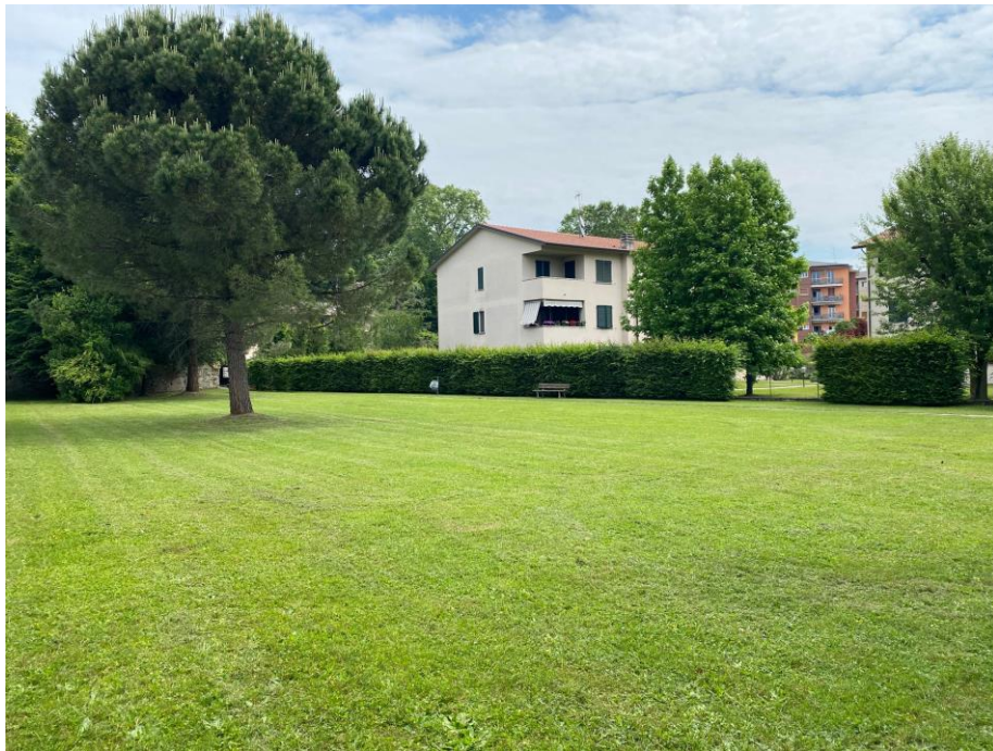
Foto da ovest verso est
