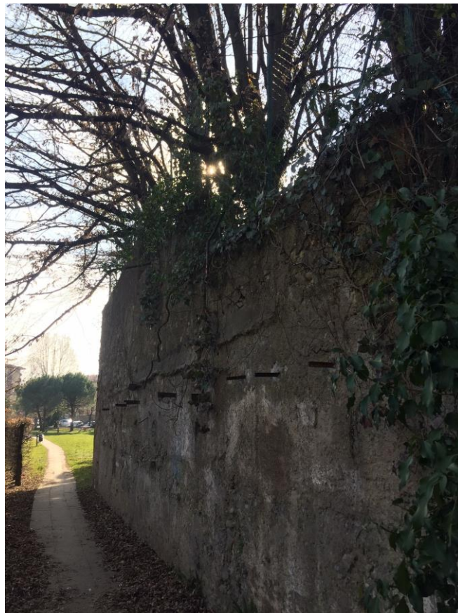
Foto da nord verso sud in corrispondenza del rocolo del Parco di Villa Confalonieri
