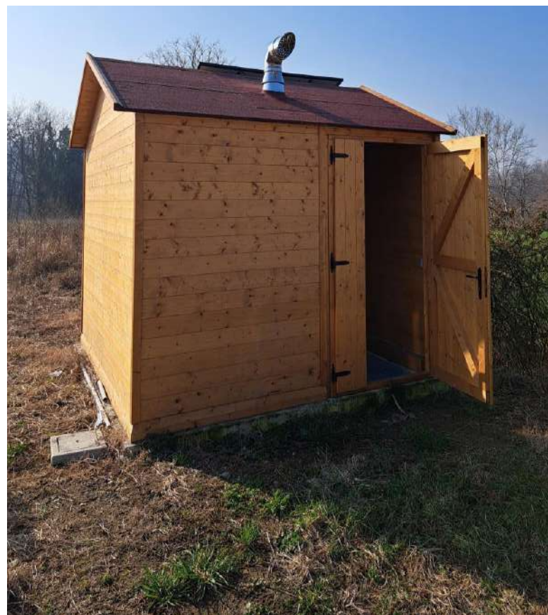
Esterno pozzo, vista casetta e condotto di aspirazione aria.
