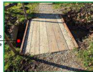
ATTUALE PONTICELLO N°2
