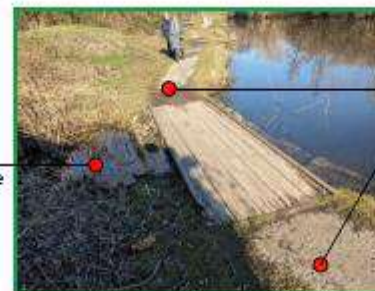
ATTUALE PONTICELLO N°1
