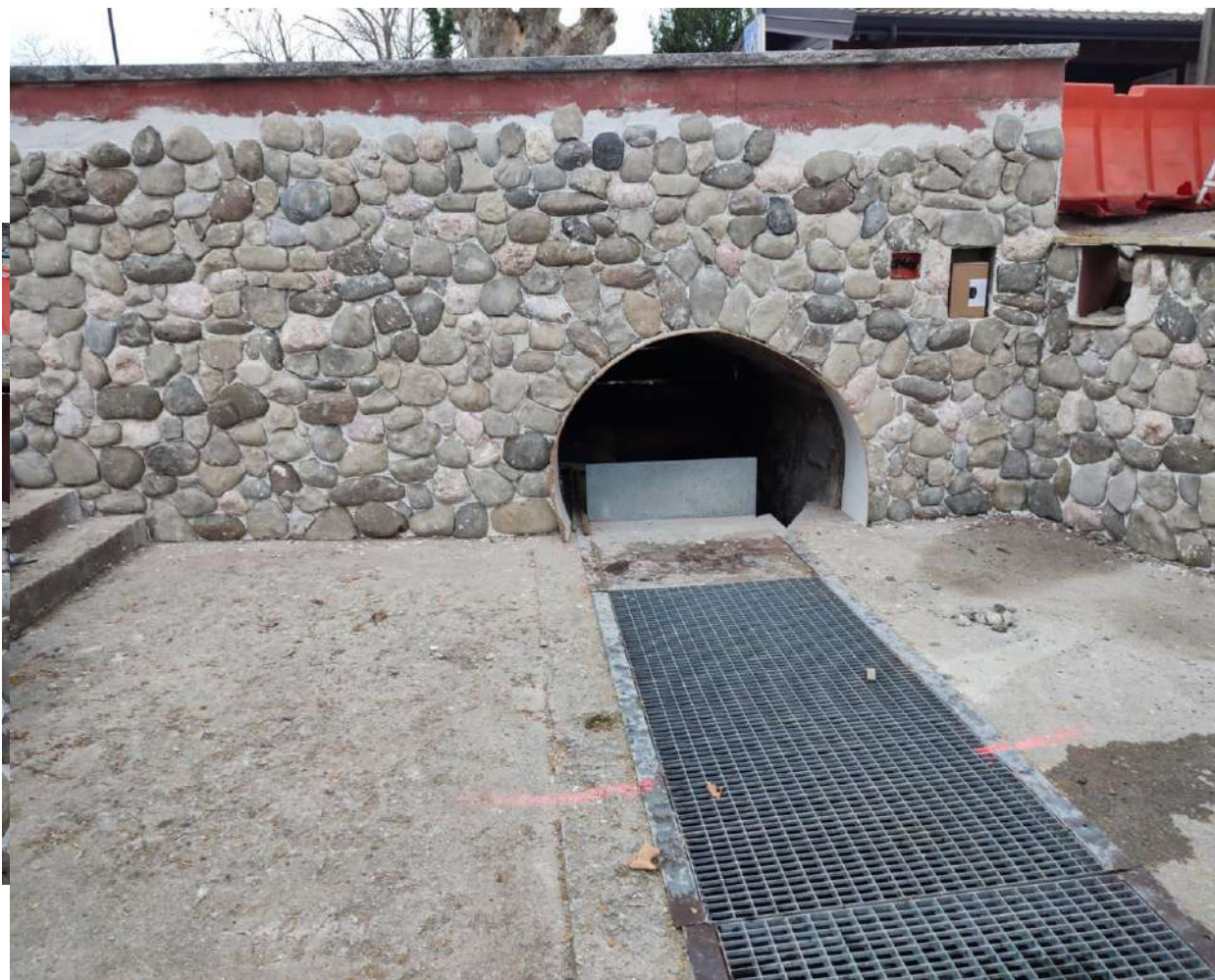
Lavori alla foce
