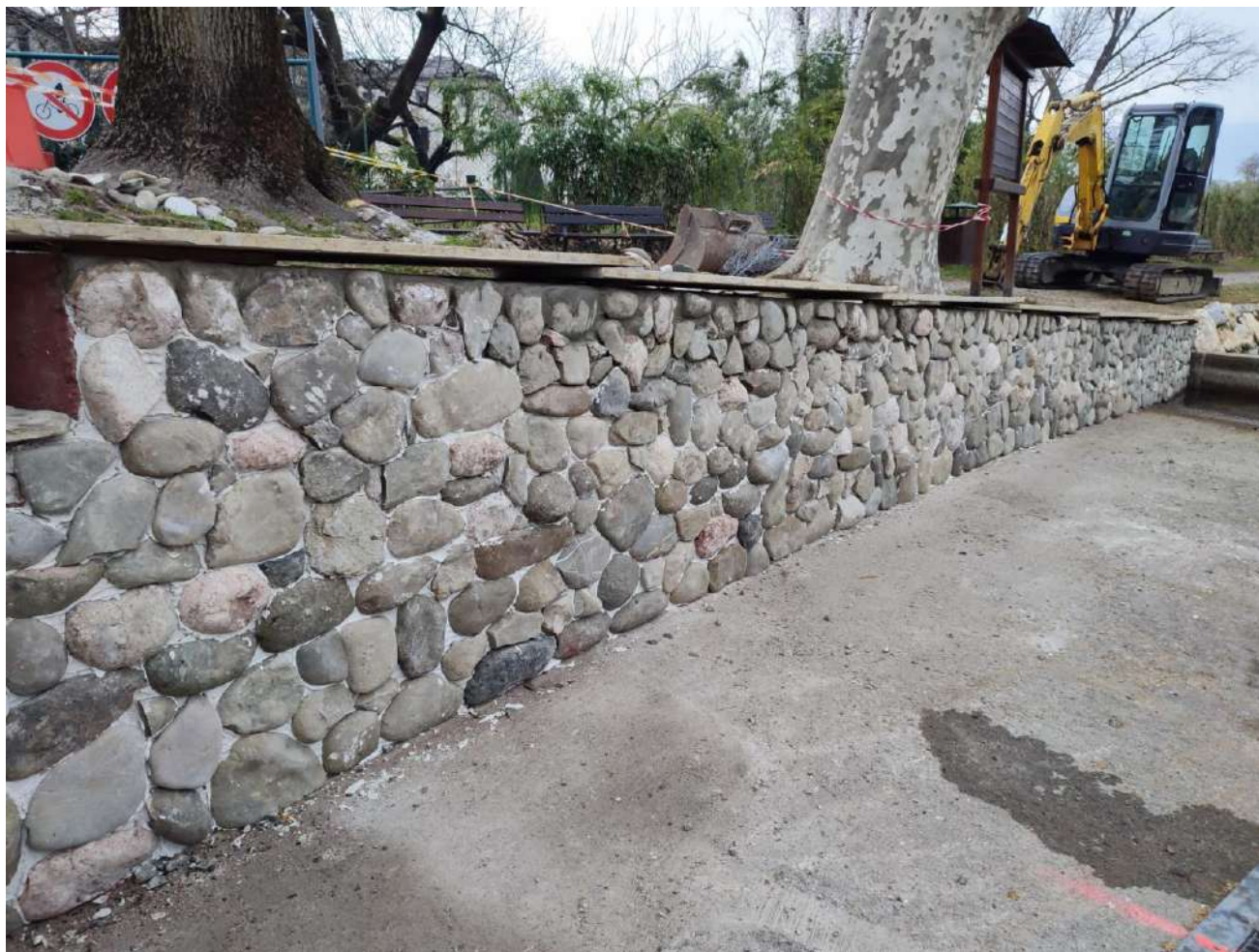
Lavori alla foce
